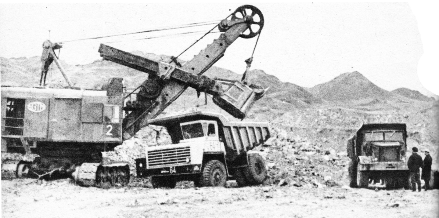
В карьерах треста «Туваасбест». Здесь работают 4-кубовые уралмашевские экскаваторы и белорусские «МАЗы».
